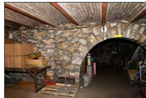
Vue du sous-sol, de ses murs en moellière et de ses voutains, 2024 (© DHAAP / ML).
